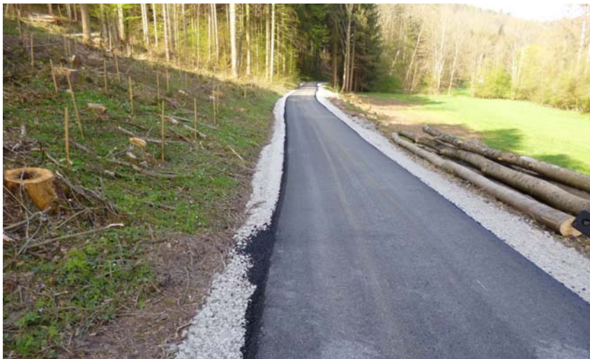
Der Radweg „Der Klassiker“ am Pfaffenbrunnen bei Wertheim-Bronnbach wurde im Frühjahr 2014 saniert.
