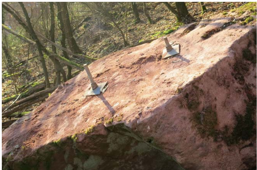
An der Landesstraße 2310 bei Wertheim wurden Steinblöcke mit Felsnägel gesichert.
