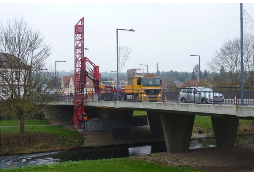
Im Rahmen der „Einfachen Prüfung“ wurde auch die Tauberbrücke in Tauberbischofsheim kontrolliert.
