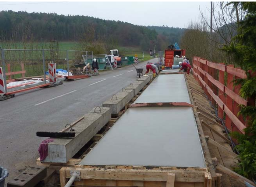
Die Gehwegkappen der Wittigbachbrücke bei Zimmern wurden erneuert.
