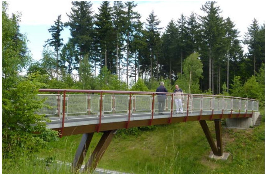
An der Geh- und Radwegbrücke über die Kreisstraße K 2877 bei Stuppach wurden der Holz-Anstrich und der Korrosionsschutz erneuert.
