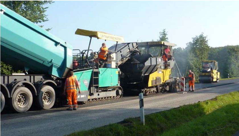
Es wurde wieder in die Fahrbahndeckensanierung investiert.
