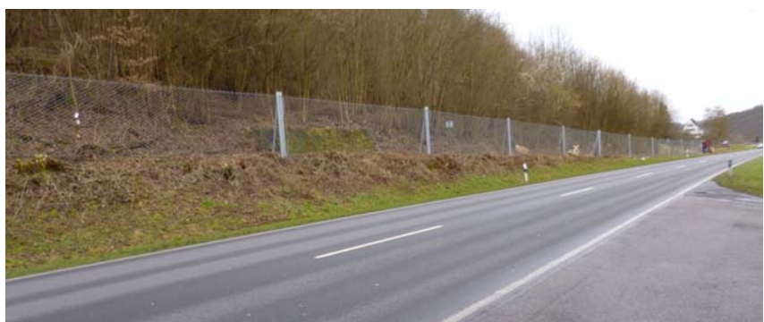
Auch ein neuer Steinschlagschutzzaun sorgt für mehr Sicherheit an der L 2310.
