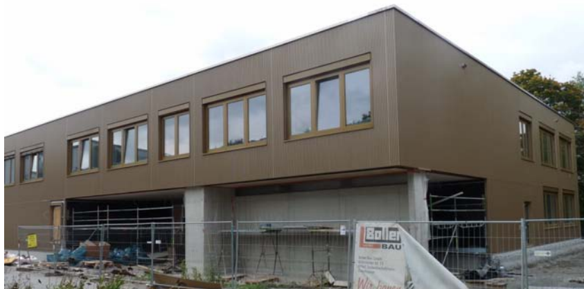
Der Neubau des Fachraumzentrums am Beruflichen Schulzentrum in Bad Mergentheim wurde im Dezember 2014 abgeschlossen.
